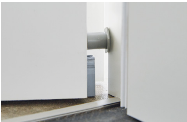
Auslöser für automatisch absenkende Bodendichtung
