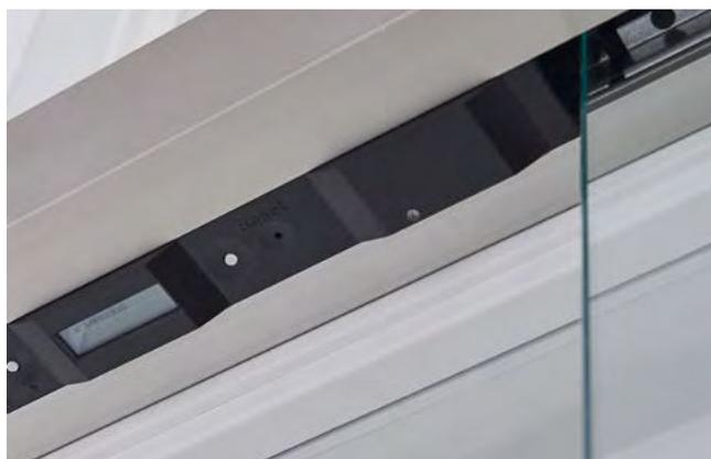
Automatischer Schiebetürbeschlag LIMATIC
